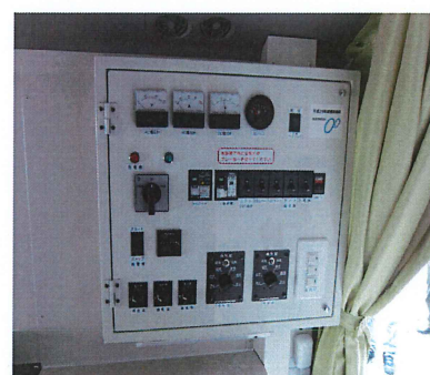
←車両後方の様子を前方撮影室で画像にて確認し、スピーカーで、入口に居られる受診者と対話が可能
